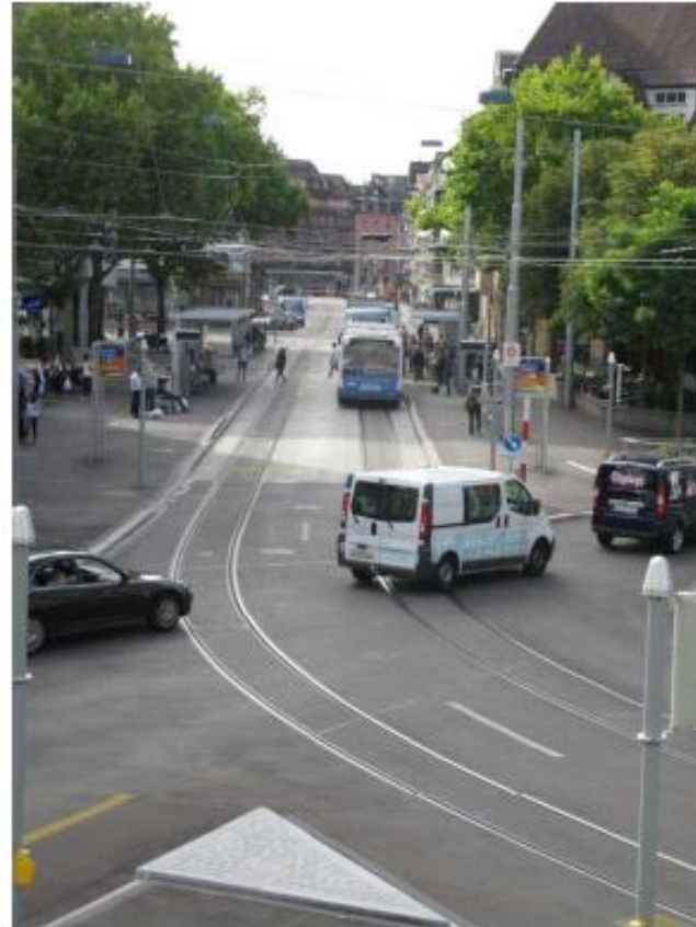
Schmiede Wiedikon, août 2011: suppression des voies de circulation TIM en direction de la sortie de ville, nouvelle organisation de l'arrêt, passage des cars postaux sur le couloir des VBZ
