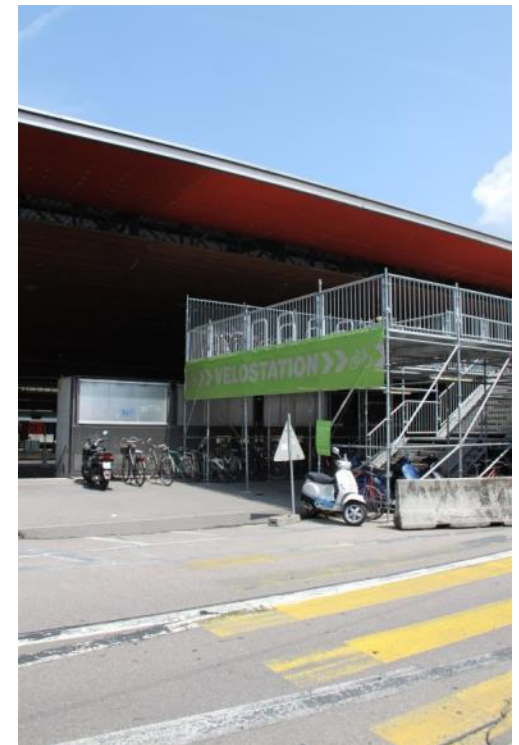
Provisorische Velostation in Zürich Foto: Tiefbauamt der Stadt Zürich
