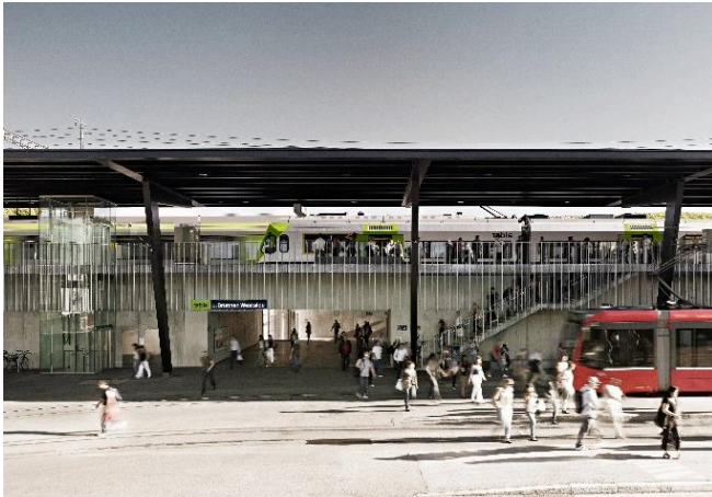
Multimodale Drehscheibe am Westside in Bern-Brünnen (Quelle: BLS)
